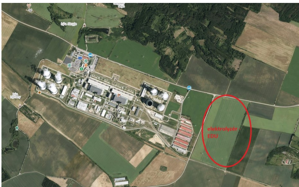
Obr. 2. Možné umístění elektrolyzéro mimo střežený prostor EDU (Lokalita Suchá louka)
